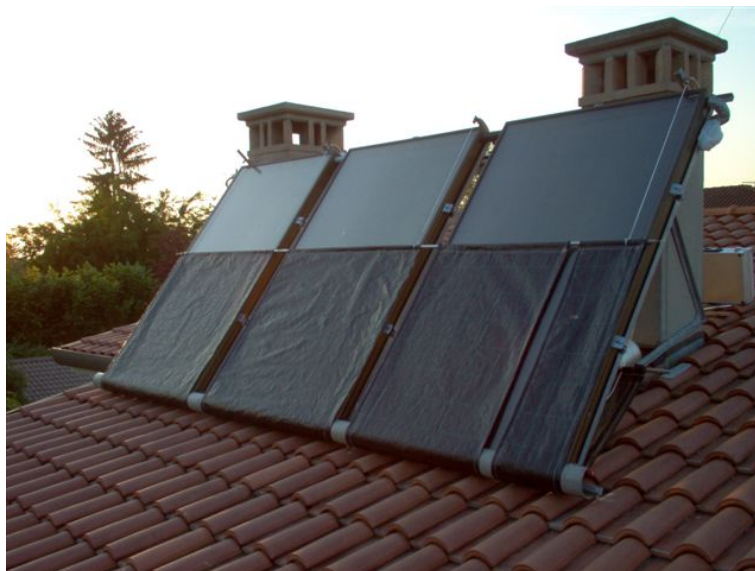
Figura 1.9: Collettori dotati di tendine elettriche per evitare la stagnazione: sistema antistagnazione del Bepi ( www.portalsole.it )
